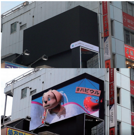
Fig. 3 トラブル中のLEDビジョンと正常な状態（渋谷区宇田川町 上 2024年6月, 下 2021年11月撮影）
